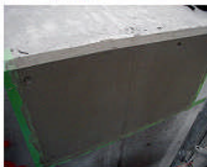
目的：高欄劣化防止
