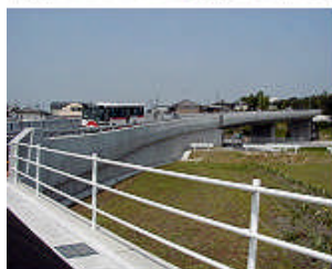
目的：高欄劣化防止
